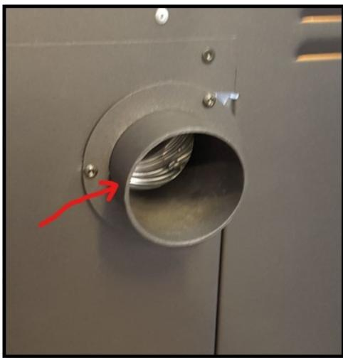
Abb. 29: Doppelanschlussstutzen montieren
