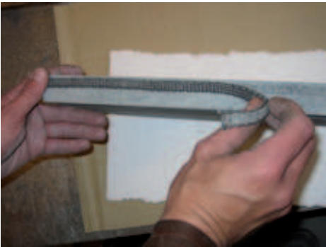
20. Unter der Kachel im Warmhaltefach das beiliegende Dichtungsband ankleben (stoßabsorbierend).
