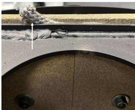
4) Fjern det lille pakningen som er montert mellom ovnen og vermiculitt.
